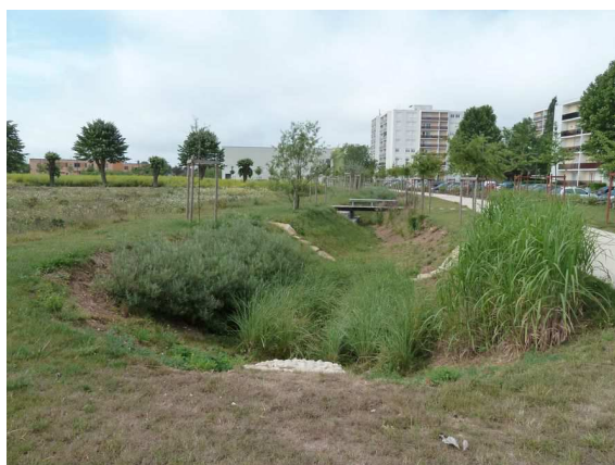
Illustration 1 : Les études de sols sont par exemple nécessaires au dimensionnement d'ouvrages d'infiltration et à la définition des conditions de terrassement et de tenue des parois des ouvrages (Ph. Cerema).
