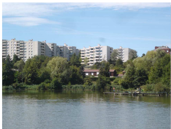
Illustration 1: Plan d'eau dans l'ancienne ville nouvelle de l'Isle d'Abeau, mobilisé pour le ralentissement et l'écrêtement des débits d'eaux pluviales (Ph. Cerema).
