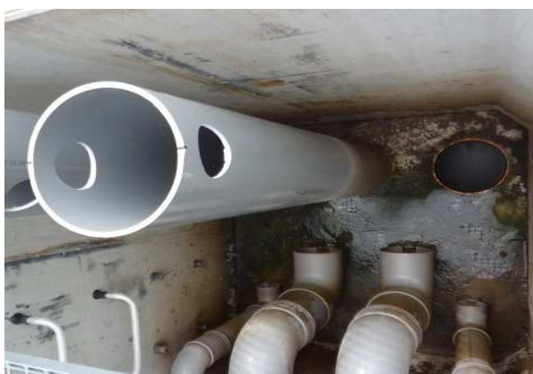
Dispositif de sélection des filtres par tuyaux amovibles
