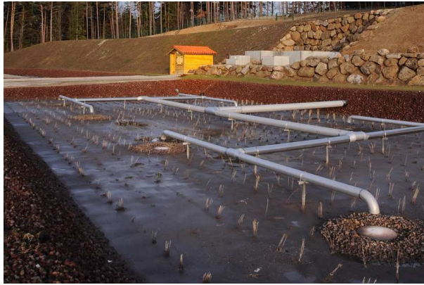
Rampe de distribution du 1 er étage
