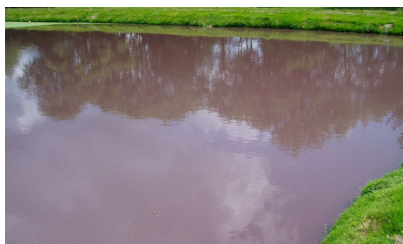
Virage au rouge d'un bassin de lagunage
