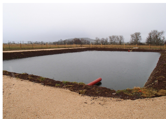
Arrivée des eaux dans un deuxième bassin
