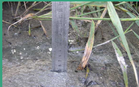
Mesure de la hauteur des boues accumulées
