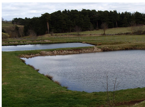
Intégration paysagère d'un lagunage naturel
