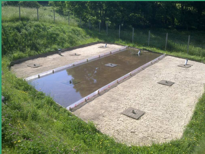
Bassin d'infiltration-percolation alimenté (section centrale) et scarifié
