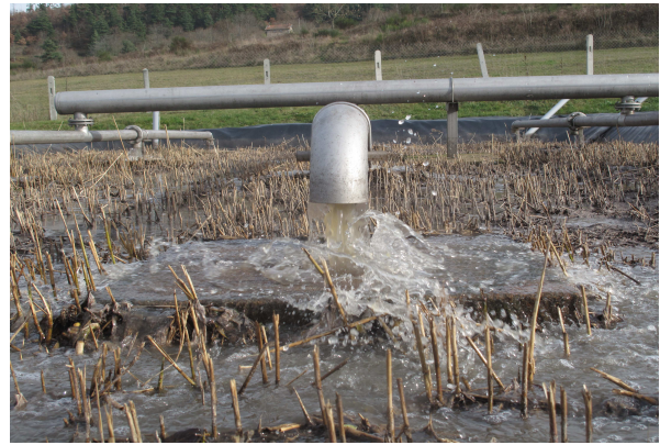
Point de distribution et système anti-affouillement
