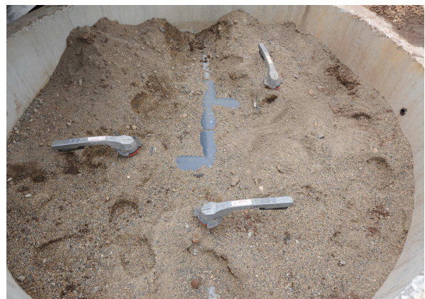
Dispositif de sélection des filtres par vannes
