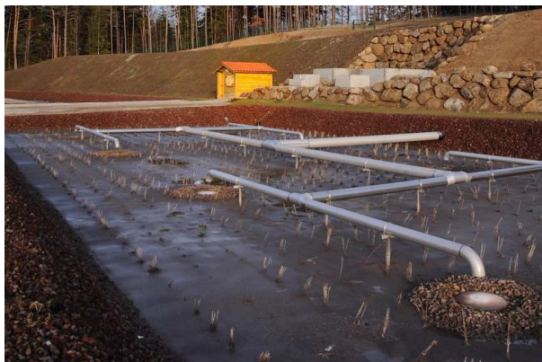
Rampe de distribution du 1 er étage
