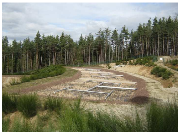
Premier étage de filtres plantés
