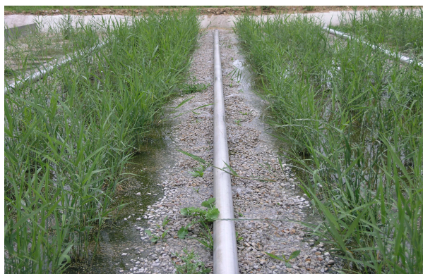
Rampe de distribution du 2ème étage
