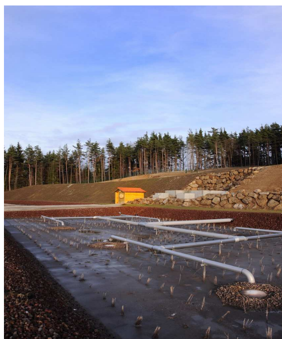
Rampe de distribution du 1 er étage
